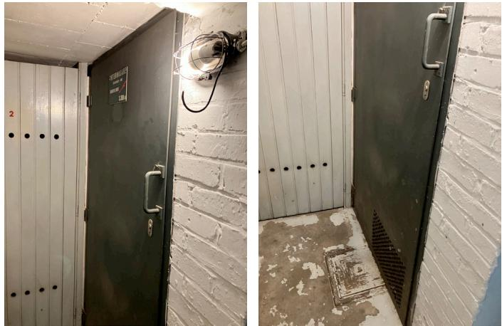
Un local chaufferie est situé en bout du sous-sol et son accès est pourvu d'une porte Rf conforme ainsi que d'une ventilation haute et basse donnant sur l'espace de parking en rez-de-chaussée. Aucune intervention n'est à mener sur ce local.
