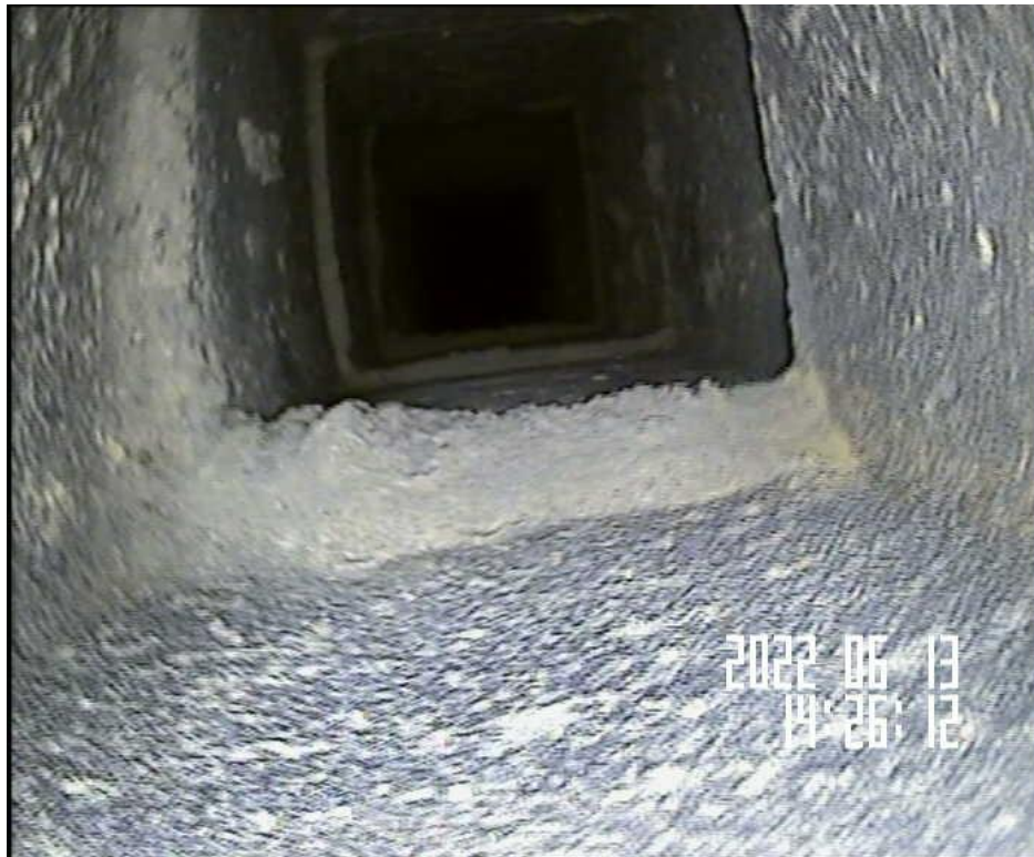
Mauvais emplant des boisseaux 200 x 200 avant dévoiement – shunt GB ADD 041 - 101
