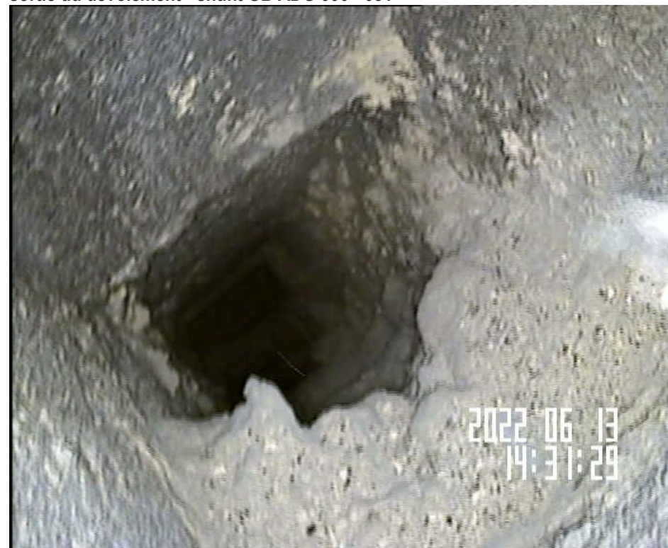
Présence de mortier retrécissant la section libre des boisseaux 200 x 200 à la sortie du dévoiement - shunt GB ADG 000 - 031
