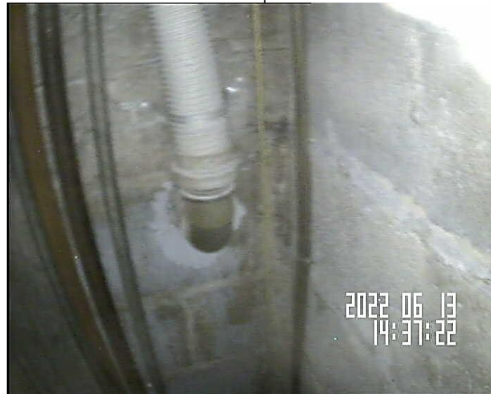
Aéra droit à hauteur du rez +8 : coude de départ avec flexible inox Ø80 mm
