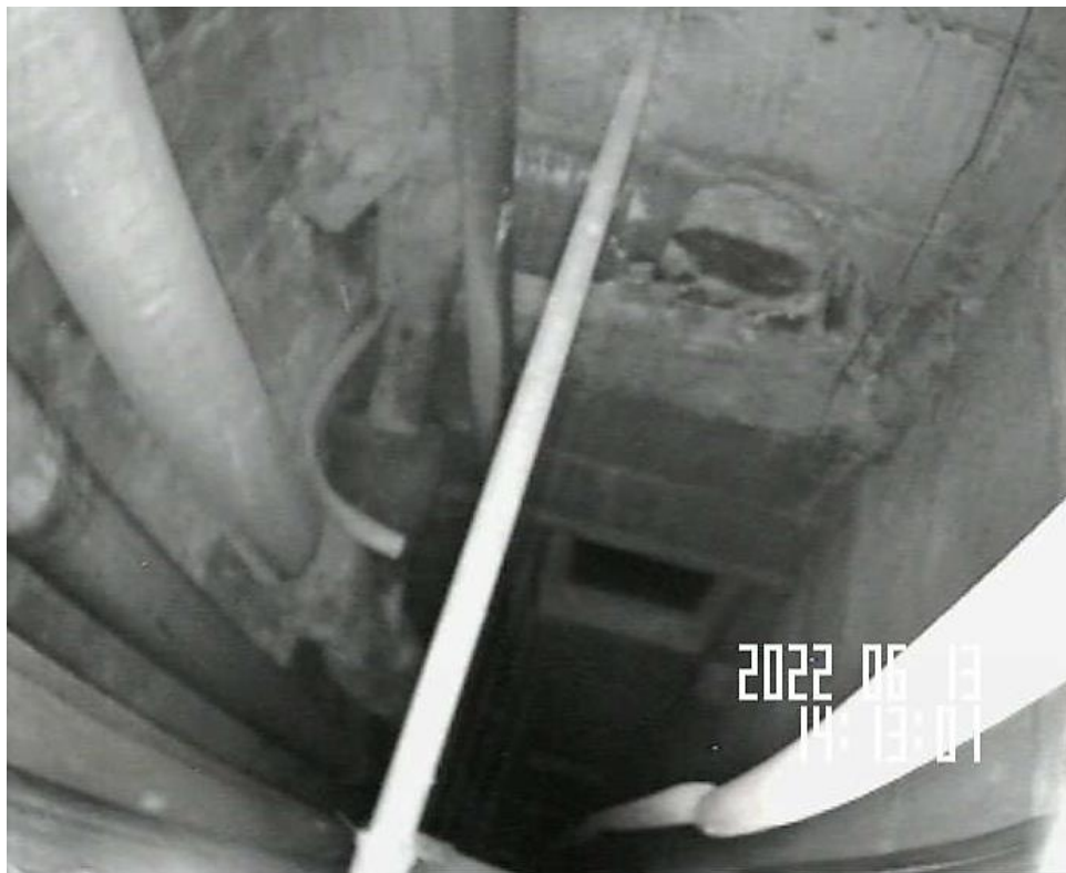
A chaque étage, aéra gauche traversé par une canalisation rigide
