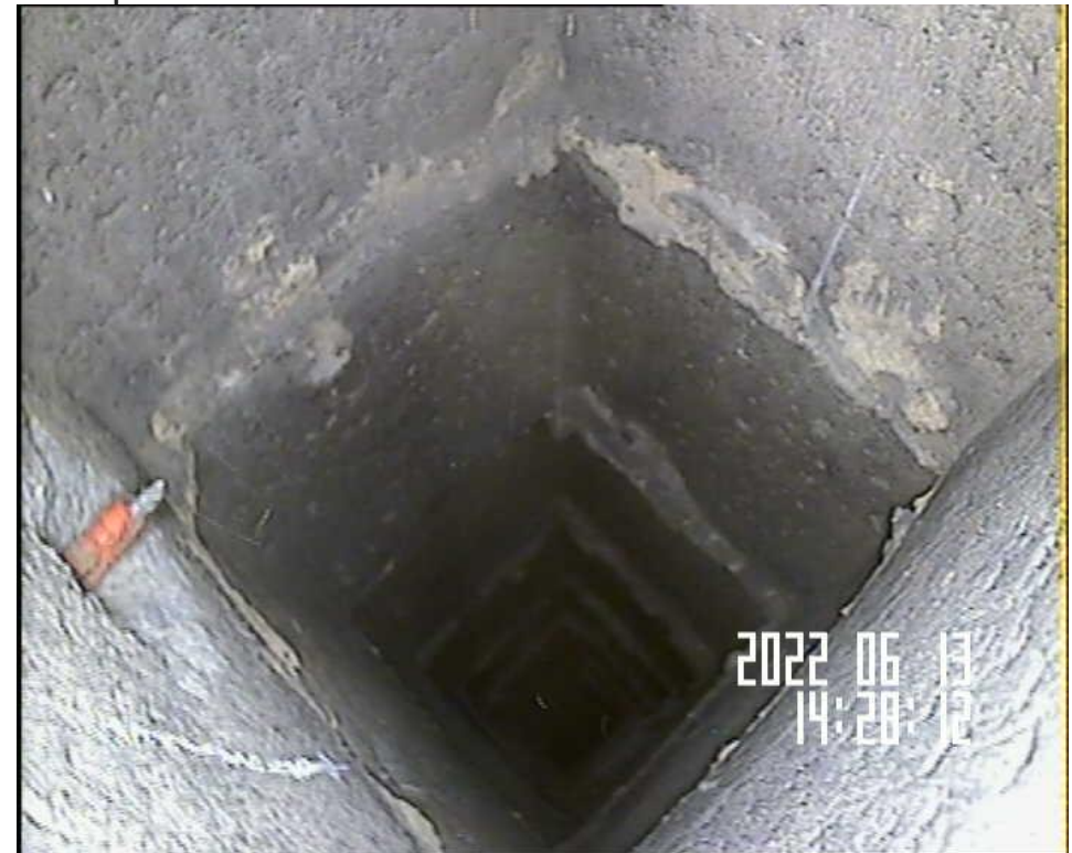
A 3 m : présence d'une vis dans le boisseau 200 x 200 du shunt ADG 000 - 031
