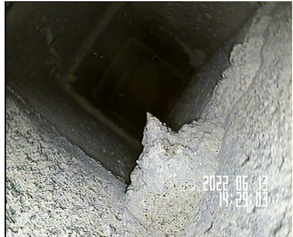
Barbe de mortier sur la section en boisseaux 200 x 200 -- shunt GB ADG 000 - 031
