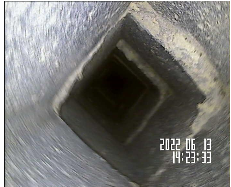
Mauvais empliment des boisseaux 200 x 200 avant dévoiement – shunt GB ADD 041 - 101
