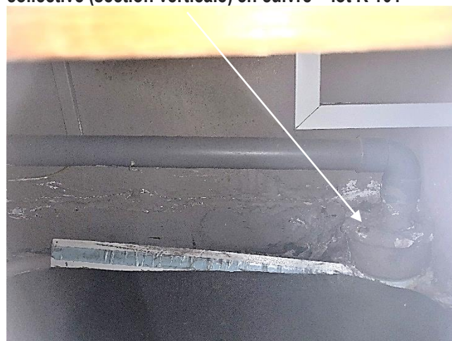
Décharge privative en PVC se repiquant sur la décharge collective (section verticale) en cuivre – lot R 101
