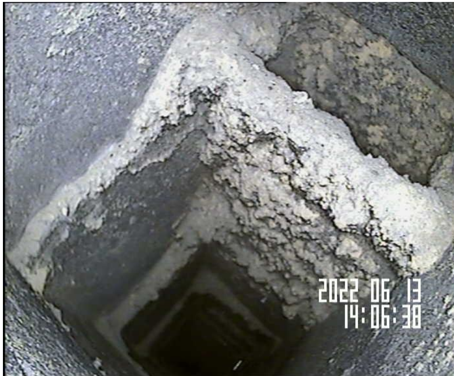
Début de la section shunt 200 x 200 – 125 x 200 après le dévoiement – shunt AGD 001-032
