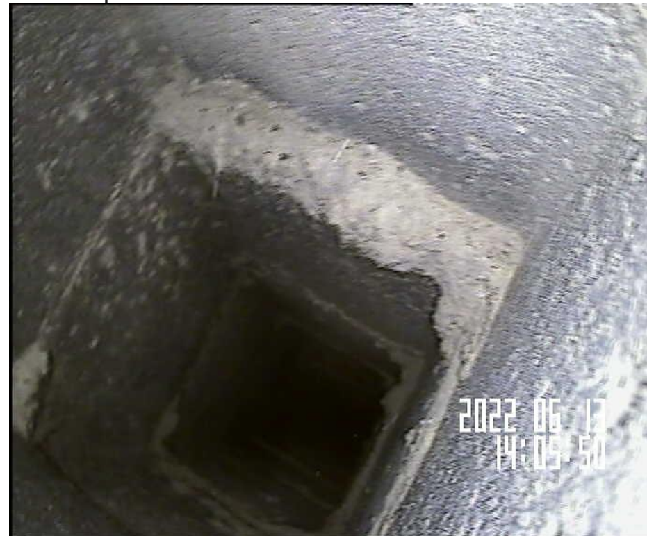
Mauvais emplant des boisseaux 200 x 200 avant dévoiement – shunt GB AGD
