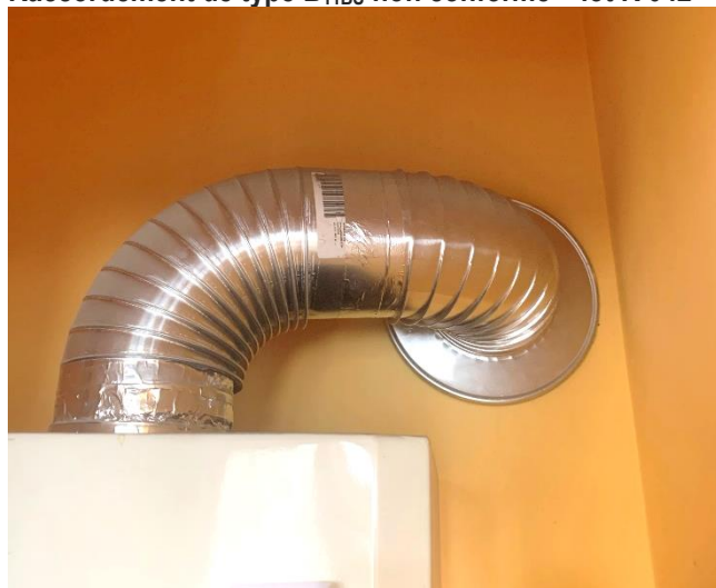
Raccordement de type B 11 BS non conforme – lot R 042
