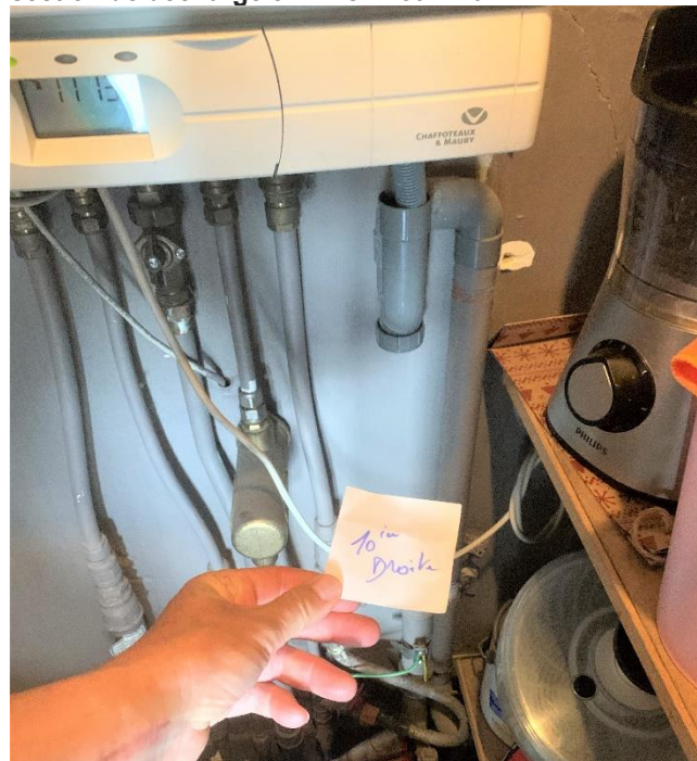
Evacuation des condensats privatifs via une nouvelle section de décharge en PVC – lot R 101
