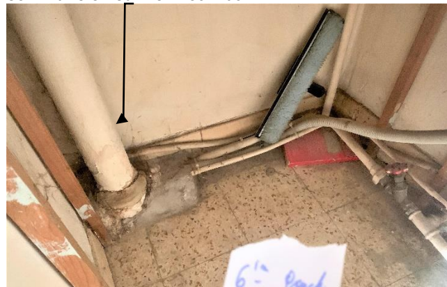
Evacuation des condensats privatifs sur la décharge commune en cuivre – lot R 062
