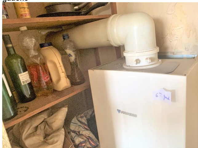
Conduit concentrique Ø 80 - 125 mm avec légère contre-pente – terminal mural débouchant en mitoyen gauche
