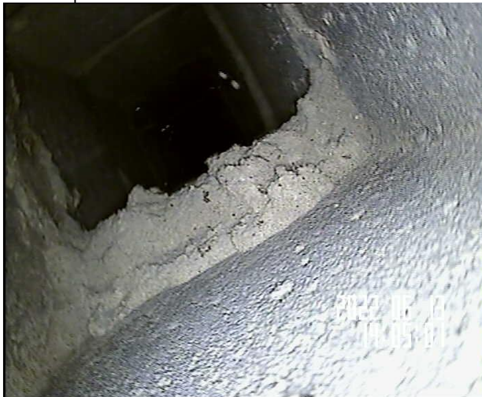
Mauvais emplant des boisseaux 200 x 200 avant dévoiement – shunt GB AGD
