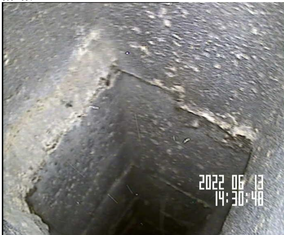
Mauvais emplant des boisseaux 200 x 200 avant dévoiement – shunt GB ADG 000 - 031
