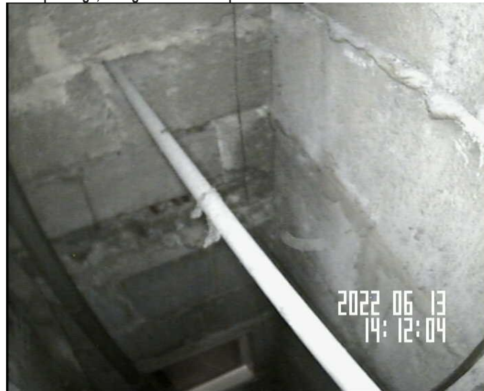
A chaque étage, aéra gauche traversé par une canalisation
