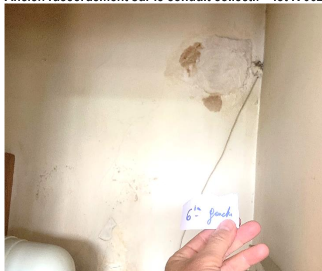
Ancien raccordement sur le conduit collectif – lot R 062
