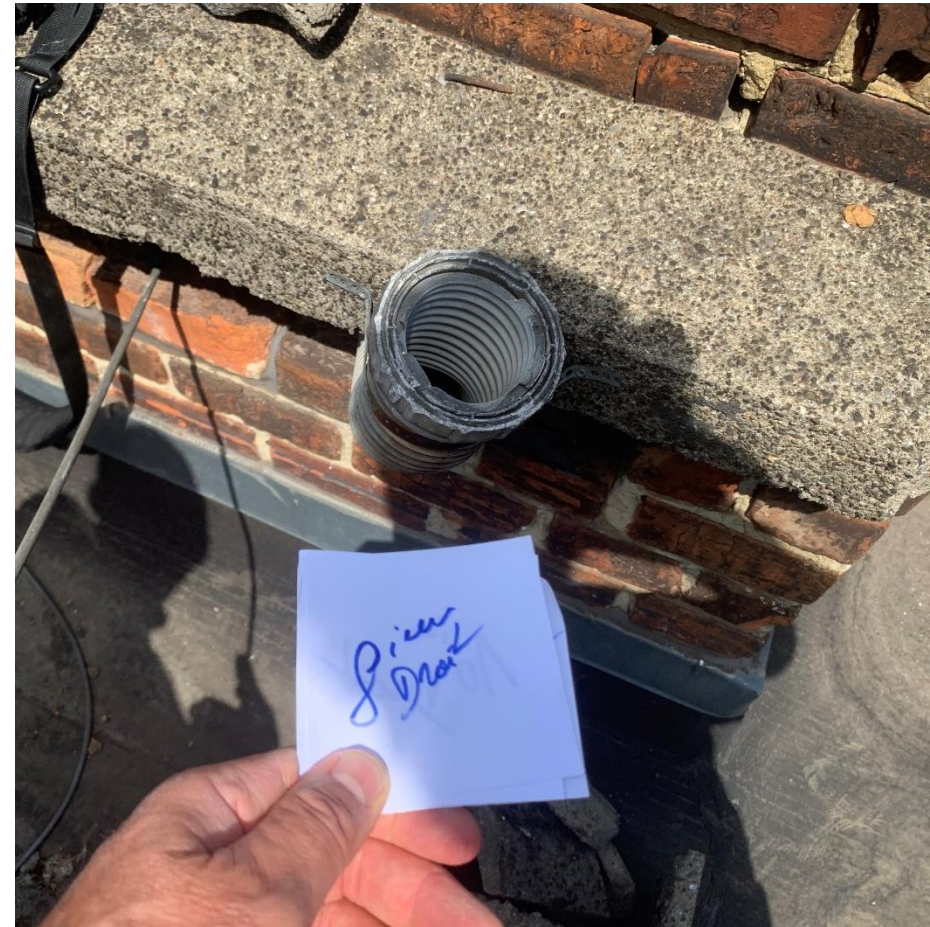
Evacuation des fumées du lot R 081 via un flexible PP dans l'aéara droit
