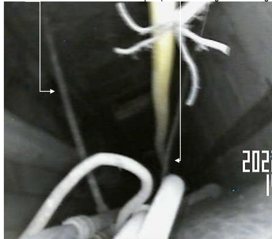
Traversées de diverses conduites techniques (canalisations rigides ou câblages)
