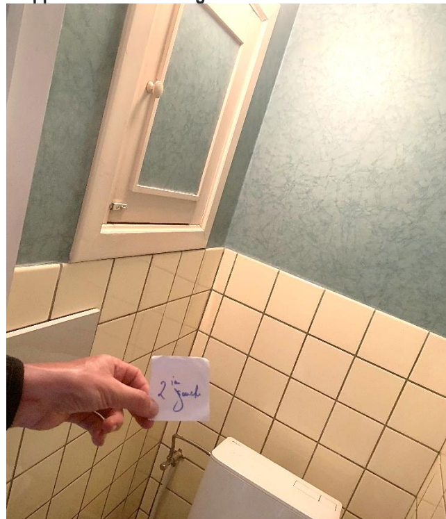
Trappe d'accès à l'aéra gauche via le wc – lot R 022
