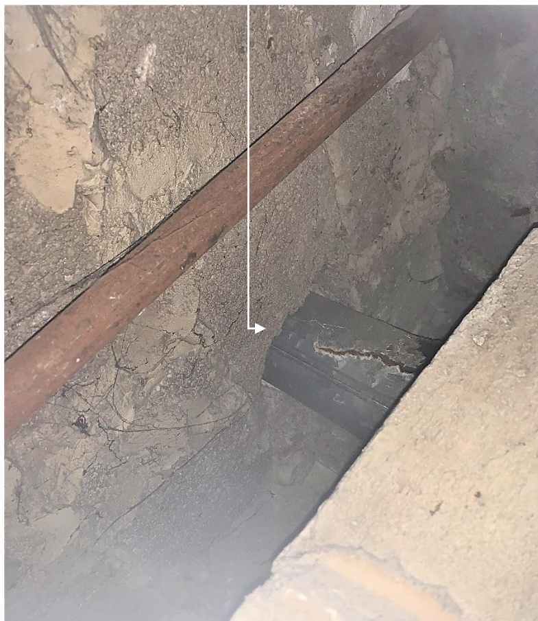
Section de raccordement de la chaudière R 001 sur le shunt AGD apparente dans l'aéra gauche
