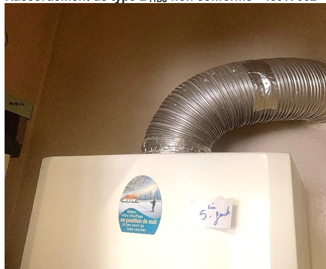
Raccordement de type B 11 BS non conforme – lot R 052
