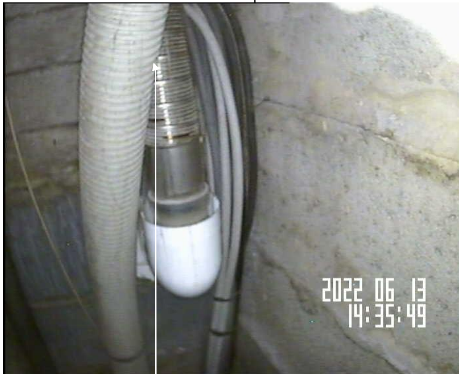
Aéra droit à hauteur du rez +10 : coude de départ avec flexible inox Ø80 mm
