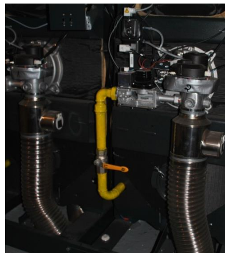
En jaune, la conduite de gaz alimentant le brûleur de la chaudière n°2 et la vanne d'arrêt
