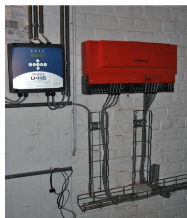
A gauche, centrale d'alarme gaz, à droite : le coffret de commande des 2 chaudières
