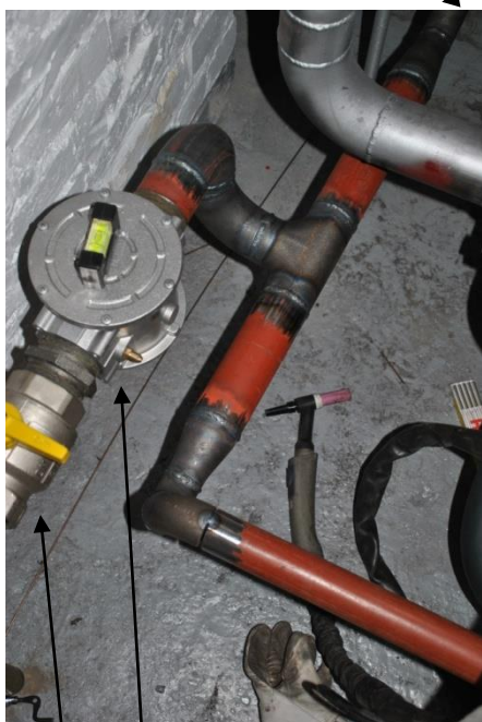
Filtre à gaz Conduite venant du compteur à gaz + vanne
