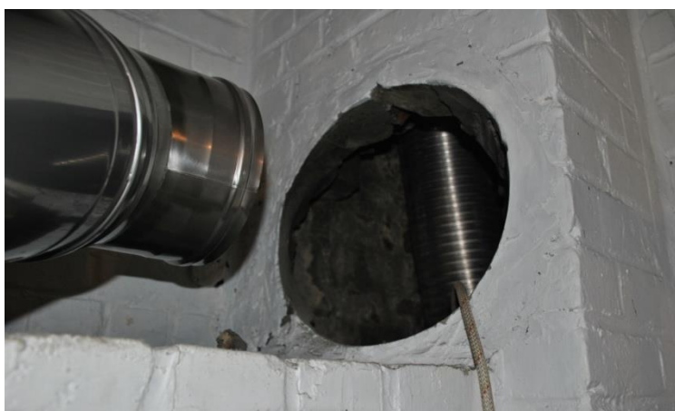
A gauche la tuyauterie des fumées venant des chaudières. A droite, dans le trou, le pied du tubage de la cheminée.
