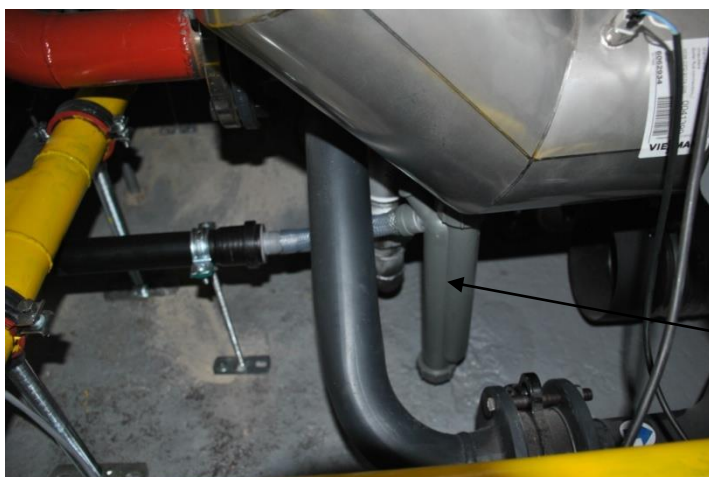
Siphon de prélèvement des eaux de condensation à la conduite des fumées de la chaudière n°1
