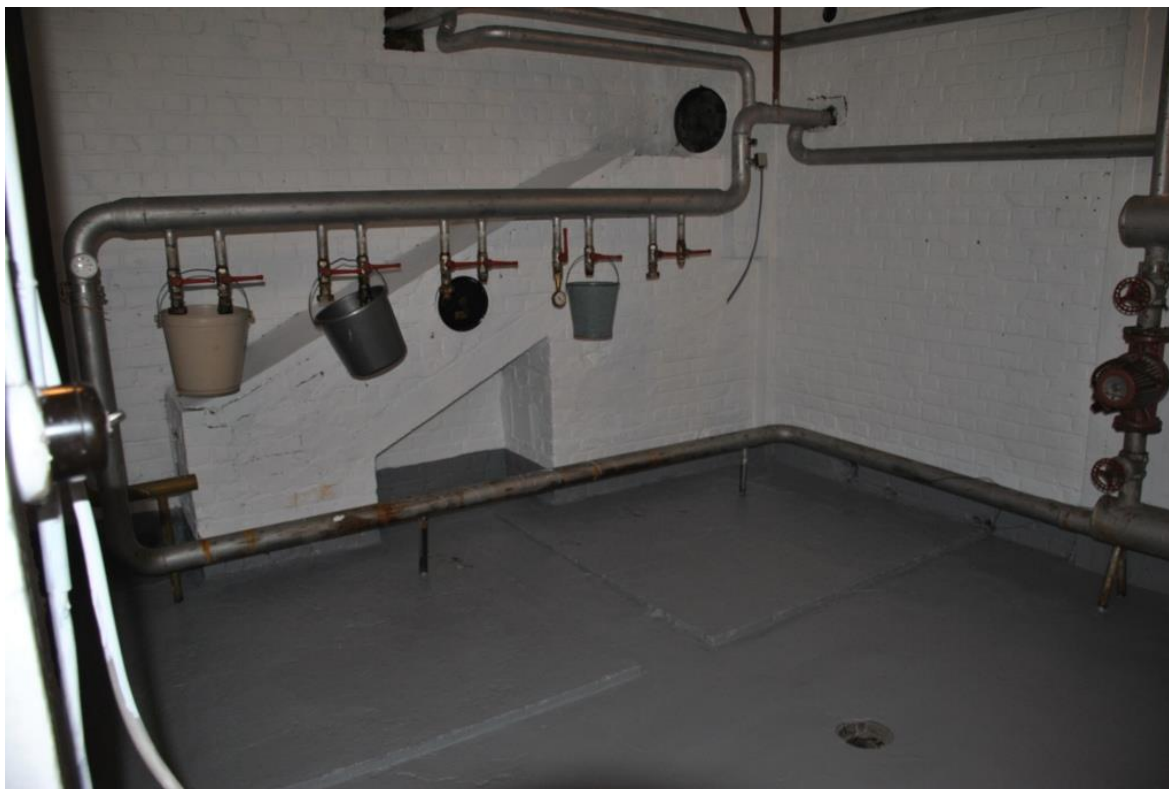
Cave chaufferie décapée au karcher, séchée et peinte. Sol réagréé , et peint de couleur epoxy
