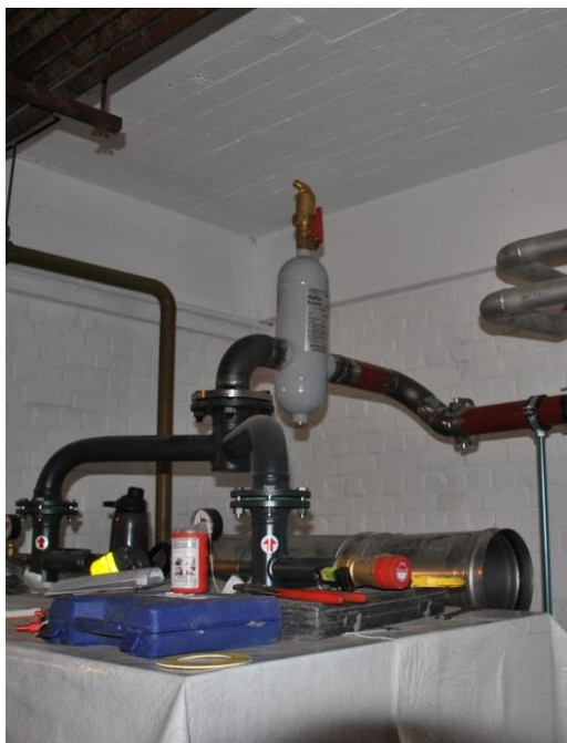
L'extracteur d'air (en gris) sur la conduite des départs d'eau chaude
