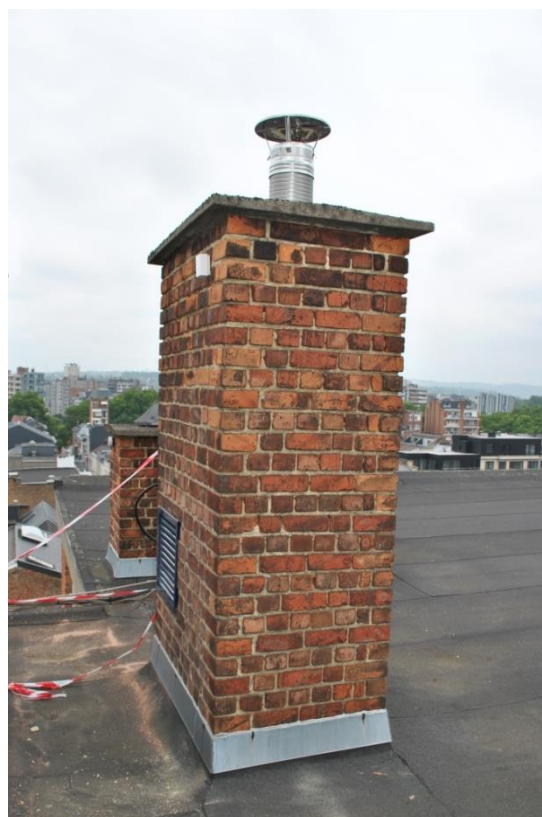
Le tubage est recoupé et recentré dans le 1 er carneau. Il reçoit son chapeau. Sur la face Nord de la cheminée : en blanc: la sonde de température et en bleu la grille de ventilation en air frais connectée au 2 e carneau.
