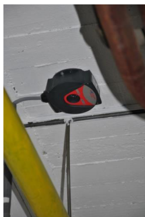
Détecteur de gaz au plafond de la cave chaufferie. Un autre se trouve dans la cave des compteurs 1
