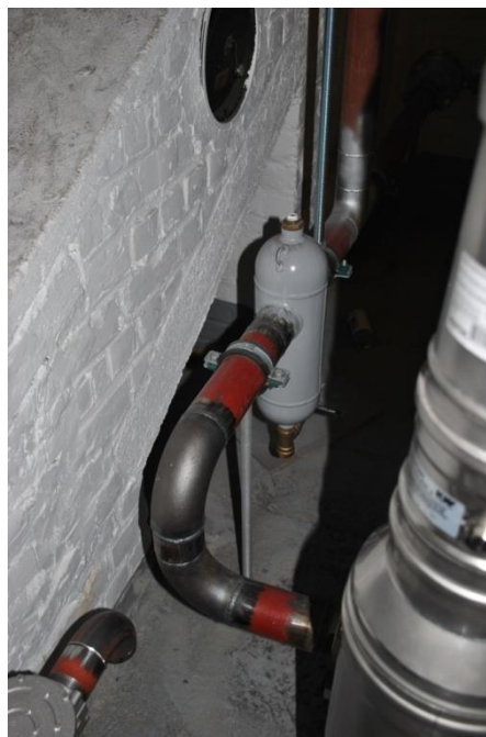
Le séparateur de boue (en gris) sur la conduite des retours d'eau froide
