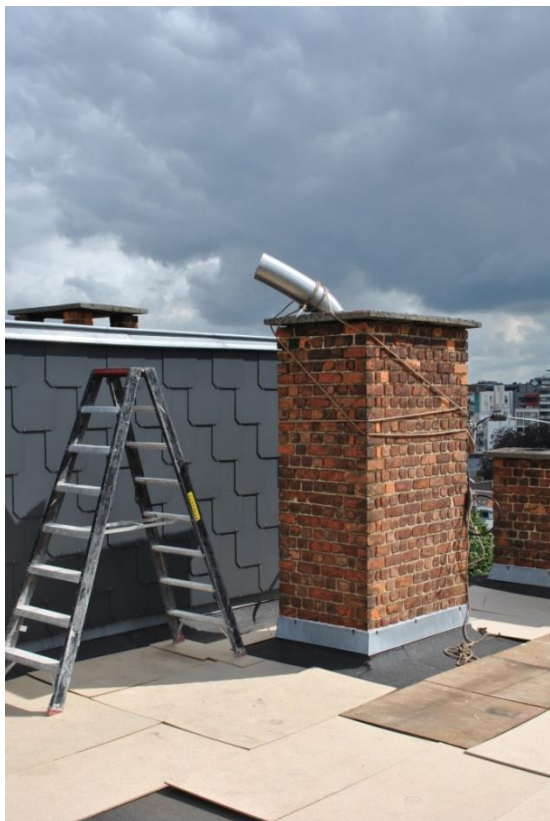
Le tubage de 35 m sort de la cheminée, momentanément suspendu par un cordage
