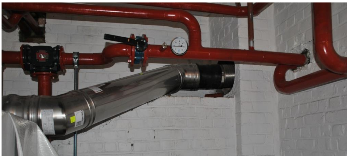
En cave, la conduite en inox relie les 2 chaudières au pied du 1 er carneau d'où sort le tubage
