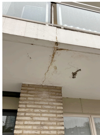
Type de fissuration à répétition
