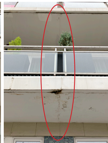
Fissuration répétée sur tous les étages
