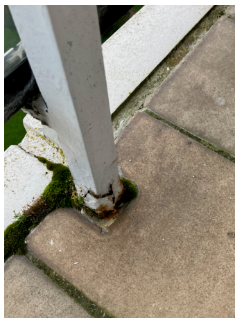
Oxydation des pieds de poteaux
