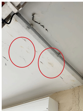
Ecaillage d'infiltration
