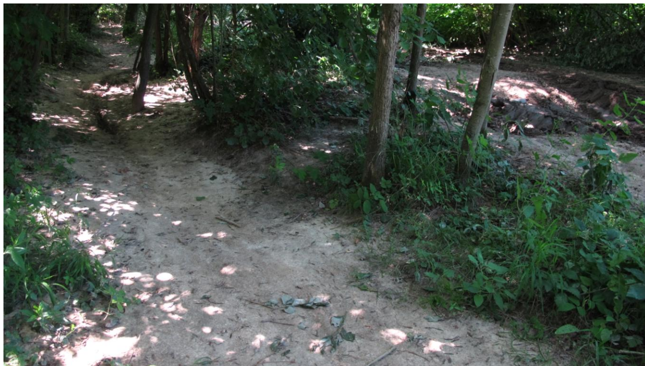
Photo 13 : Dépôts de terre, érosion et comblement du fossé sur le chemin agricole en aval du champ.
