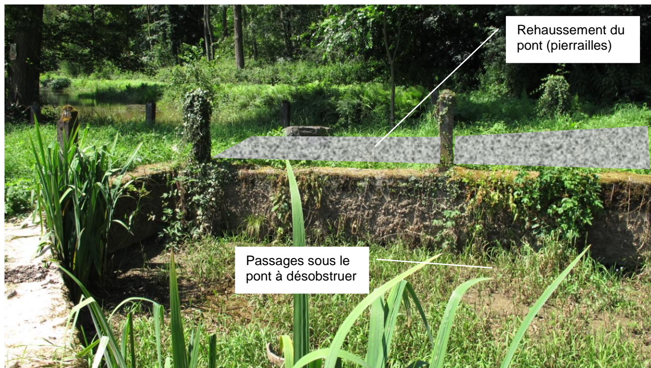
Photo 23 : Interventions conseillées au niveau du pont.
