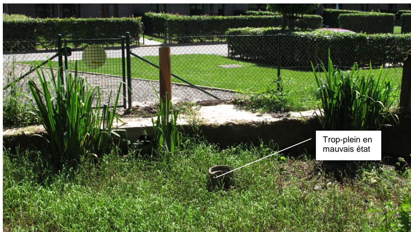
Photo 24 : Détail du trop-plein à réover.
