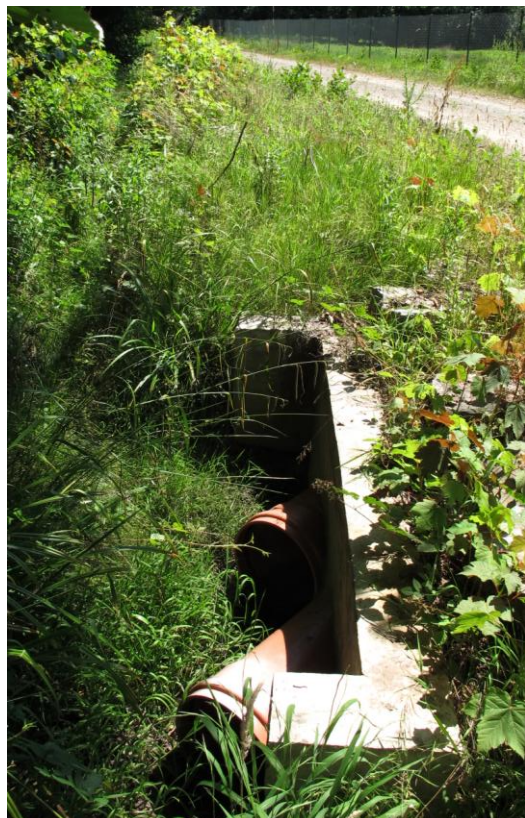
Photo 27 : Tête de conduite d'évacuation à adapter.
