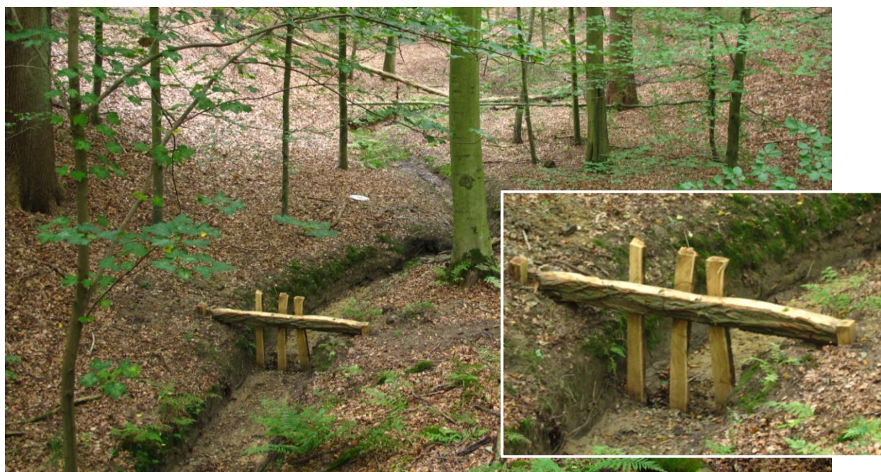
Photo 26 : Exemple de dispositif de ralentissement (en forêt de Soignes, réalisation IBGE).
