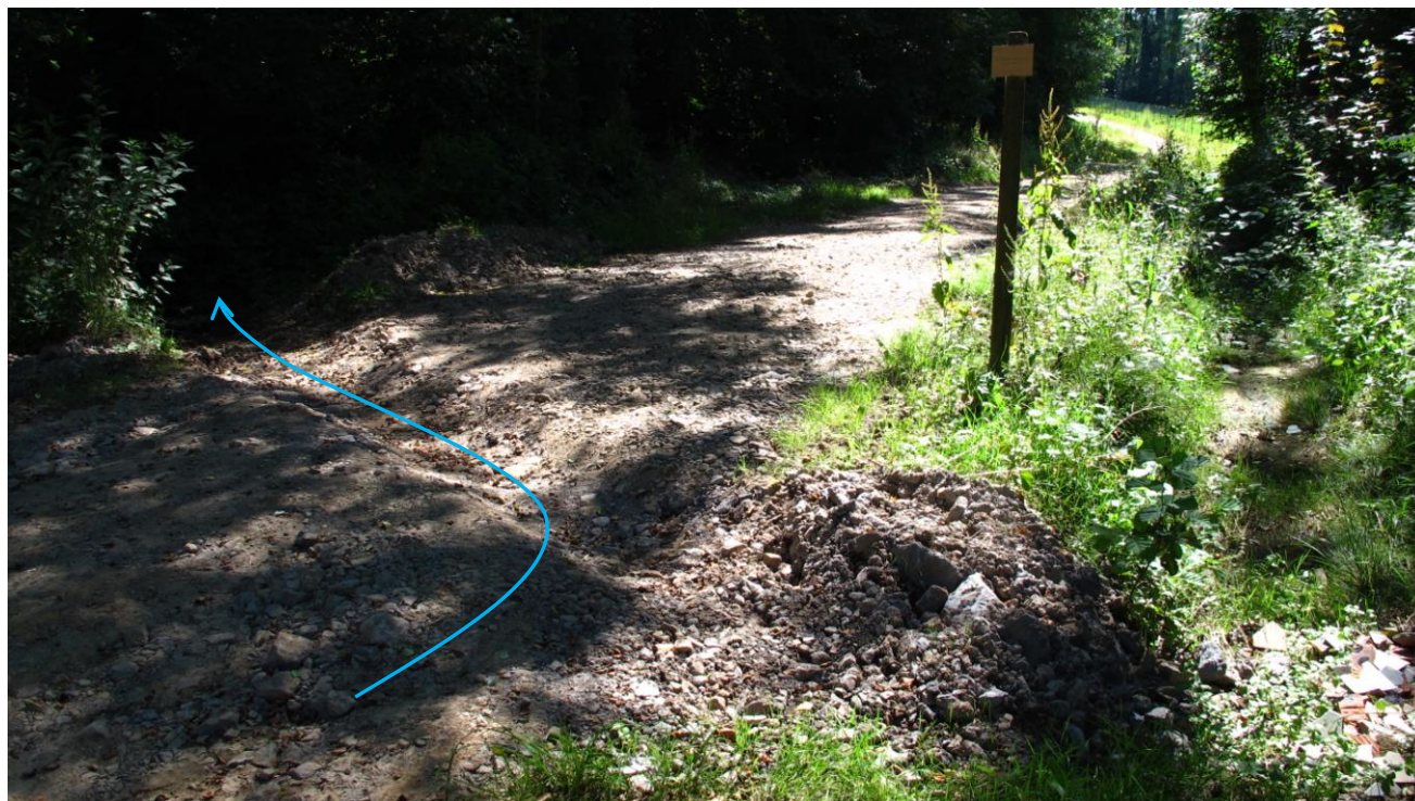
Photo 15 : Rigole (revers d'eau) créée par les services communaux – ce dispositif est placé correctement pour diriger les eaux vers le bois (en contrebas). Il devrait être pérennisé (stabilisé).
