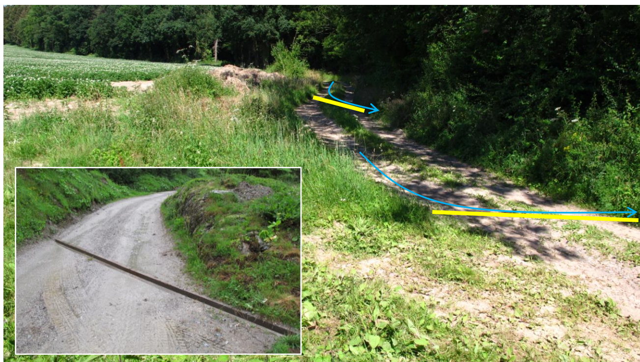
Photo 16 : Exemple de positionnement des revers d'eau.
