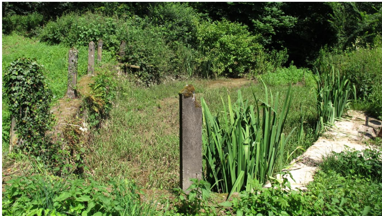
Photo 22 : Partie nord de la noue, complètement envasée, elle n'offre plus un volume de retenue efficace.
