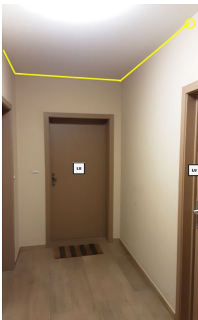
Cheminement 9, parcours en câble apparent à coller pour la connexion des unités.
