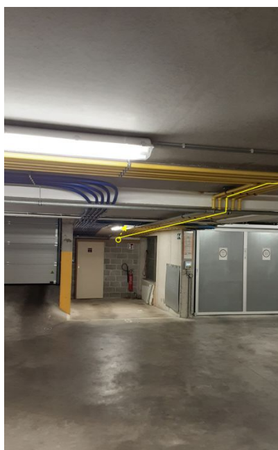
Cheminement 2, création d'une colonne verticale sous forme de goulottes en plastique avec percement à réaliser
