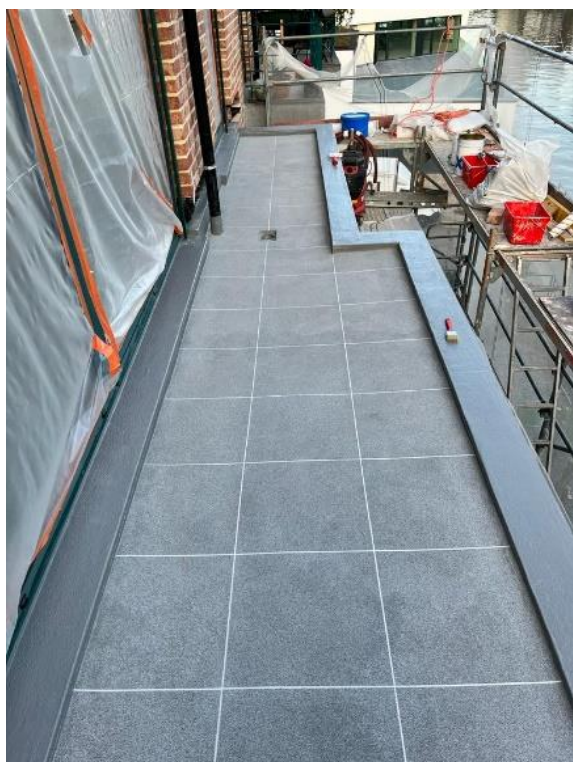
Exemple de réalisation : Rénovation d'un balcon avec revêtement en étanchéité liquide imitation carrelage
